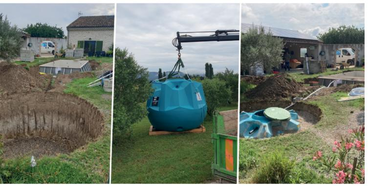
Le récupérateur d'eau d'Aquilus régule le niveau d'eau de la piscine de manière efficace. Il stocke l'eau excédentaire lors de "trop-pleins" et la réintroduit dans le bassin grâce à une pompe immergée. Un capteur mesure précisément l'eau manquante, assurant ainsi un contrôle optimal. Pour réduire l'évaporation, il est conseillé d'associer le récupérateur à une couverture de bassin, permettant une gestion raisonnée et optimale de l'eau et une consommation réduite.
